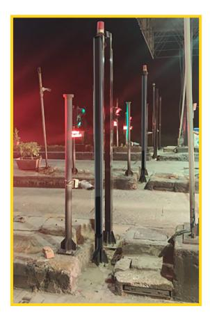
Le barriere Micron, poste al uscita di ogni corsia per il pagamento pedaggio, tramite l'interfaccia seriale RS 485 possono essere collegate ad un controller e trasmettere lo stato dei raggi:
