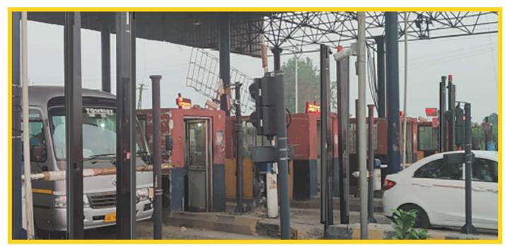
Quando il veicolo supera il varco, dopo il pagamento del pedaggio il sistema di classificazione automatica crea il profilo del veicolo e automaticamente il sostware di gestione genera un rapporto per la verifica incrociata dei dati.
